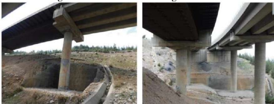
9-rasm. Nurdağı viadukining konstruktiv elementlari ko'rinishlari: plastik deformatsiyalangan temir-beton tayanch va yig'ma beton hamda po'lat oraliq qurilmalar
