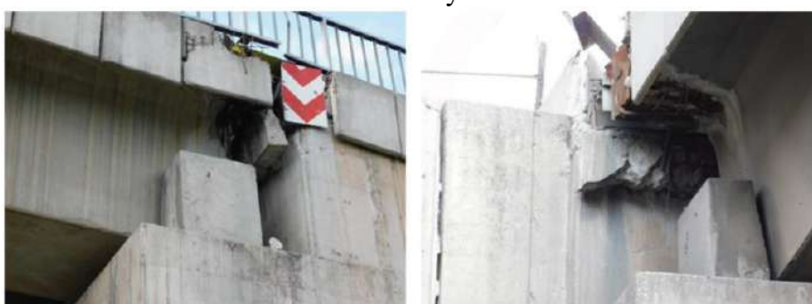
11-rasm. Nurdag'i viadukidagi chetki tayanchda kuzatilgan shikastlanishlar
