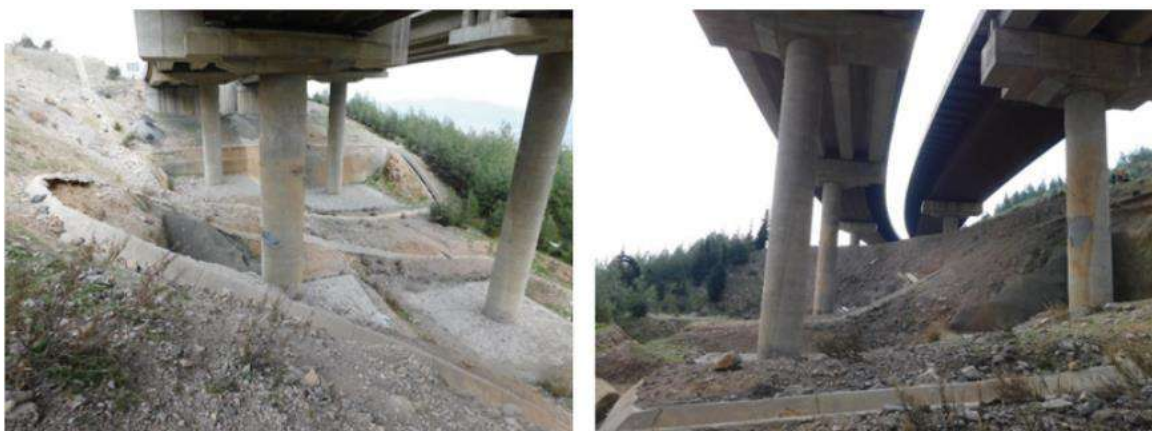
12-rasm. Nurdag'i viadukining diametri 3 m bo'lgan temir-beton tayanchining yaqinlashuv yo'li (ko'tarma) bilan birikkan chetki zonasida kuzatilgan plastik deformatsiya turlari
