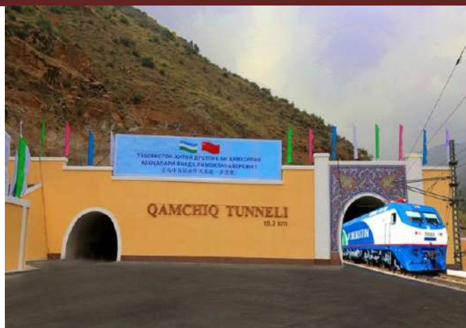
3-rasm. Qamchiq dovonidagi 19.2 km uzunlikdagi tunnel inshooti
