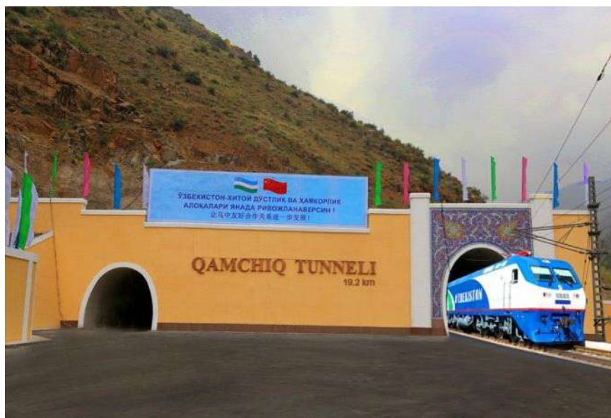
2-расм. Қамчиқ довонидаги 19.2 км узунликдаги тоннел иншооти
