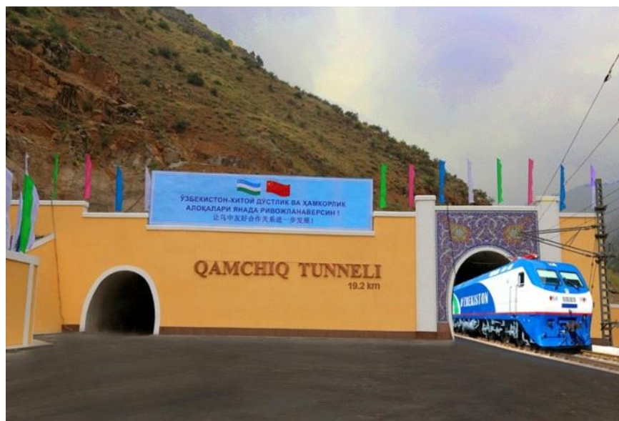
2-расм. Қамчиқ довонидаги 19.2 км узунликдаги тоннел иншооти
